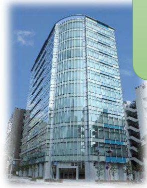
<正面からの外観>
